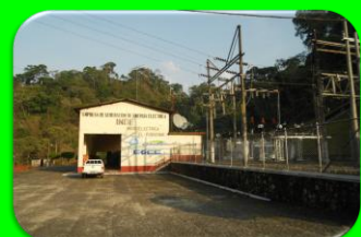
Hidroeléctrica El Porvenir
