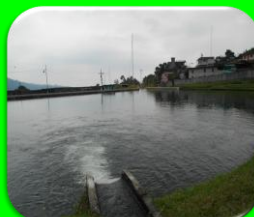
Hidroeléctrica El Porvenir
